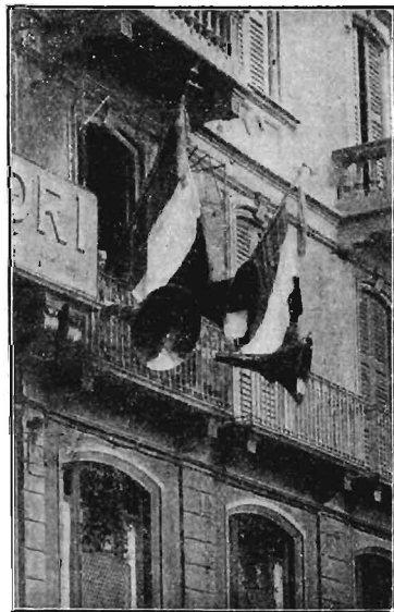
FIG. 1 - IMPIANTO DI TRE GRANDI ALTOPARLANTI A TROMBA PER LA TRASMISSIONE DI UN DISCORSO ALL'APERTO.
