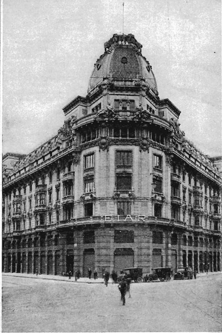
LA SEDE DELLA DIREZIONE GENERALE DELL'E.I.A.R. A MILANO.
